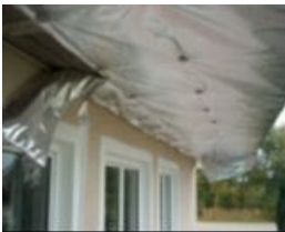
Izolace balkónu + sklepních stropů
