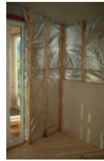
Stavba za sucha
